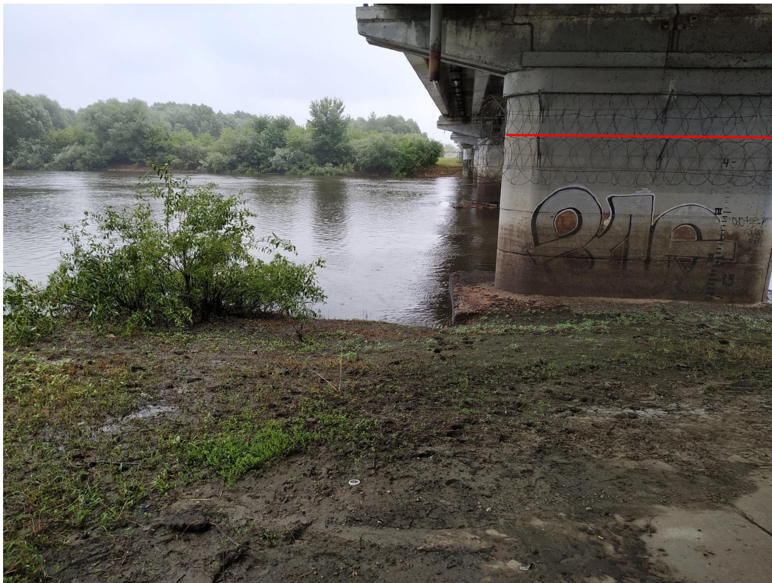
Рисунок 9.8 – Река Десна, отметки высоких вод
